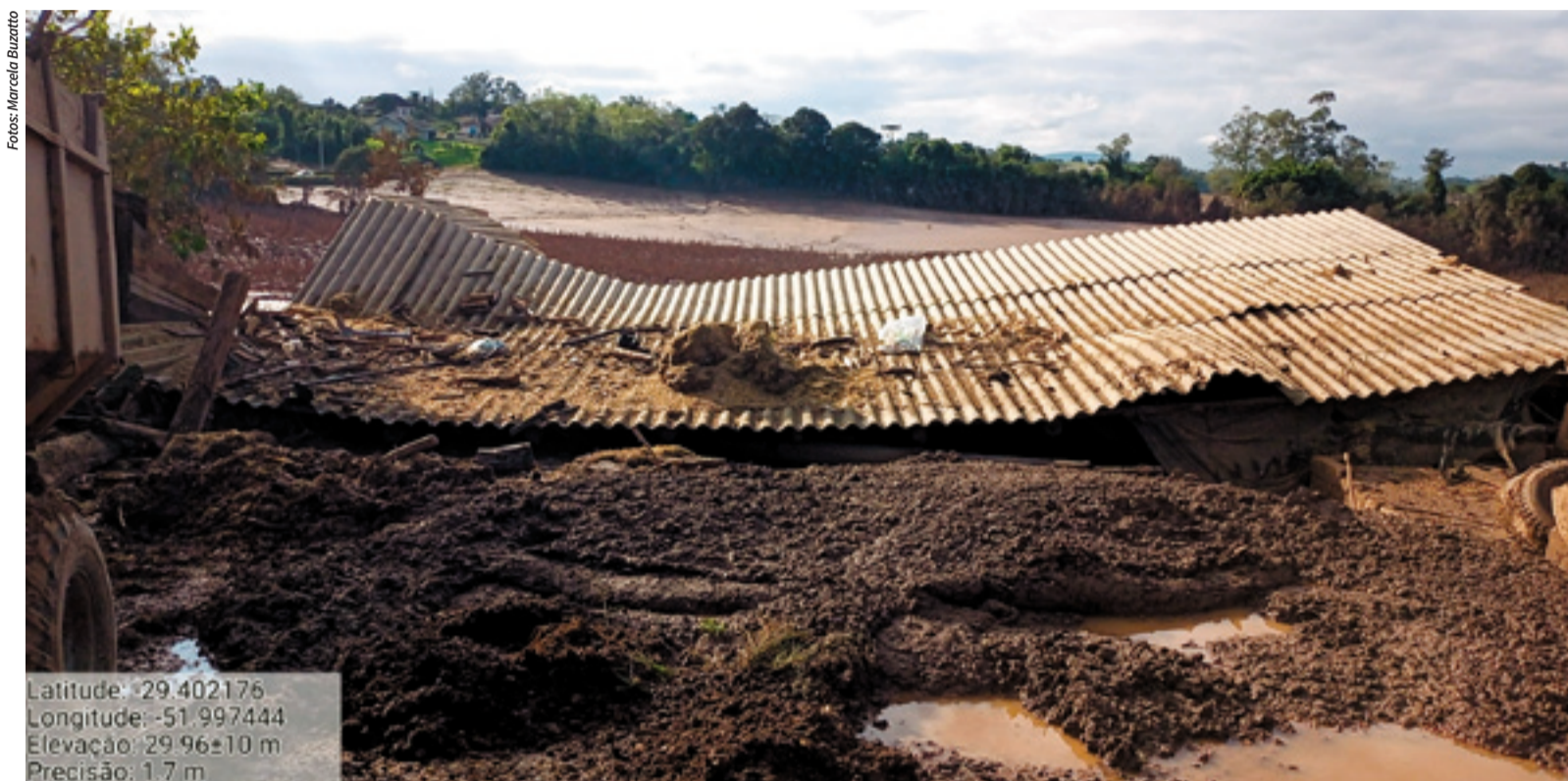
Cenários de completa destruição da paisagem e da infraestrutura podem ser observados em várias regiões do Rio Grande do Sul, em especial nas áreas dos vales
