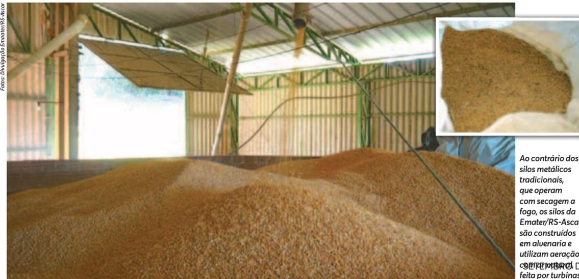
Ao contrário dos silos metálicos tradicionais, que operam com secagem a fogo, os silos da Emater/RS-Ascar são construídos em alvenaria e utilizam aeração natural com turbinas.
